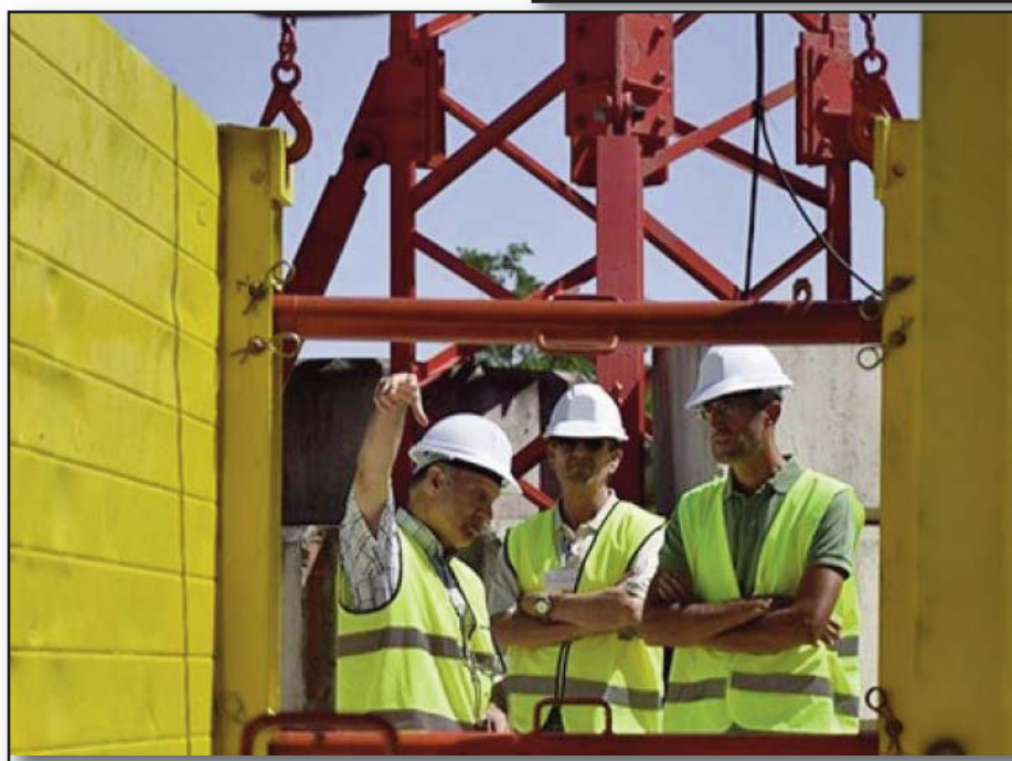
Demostración de entibación modular
