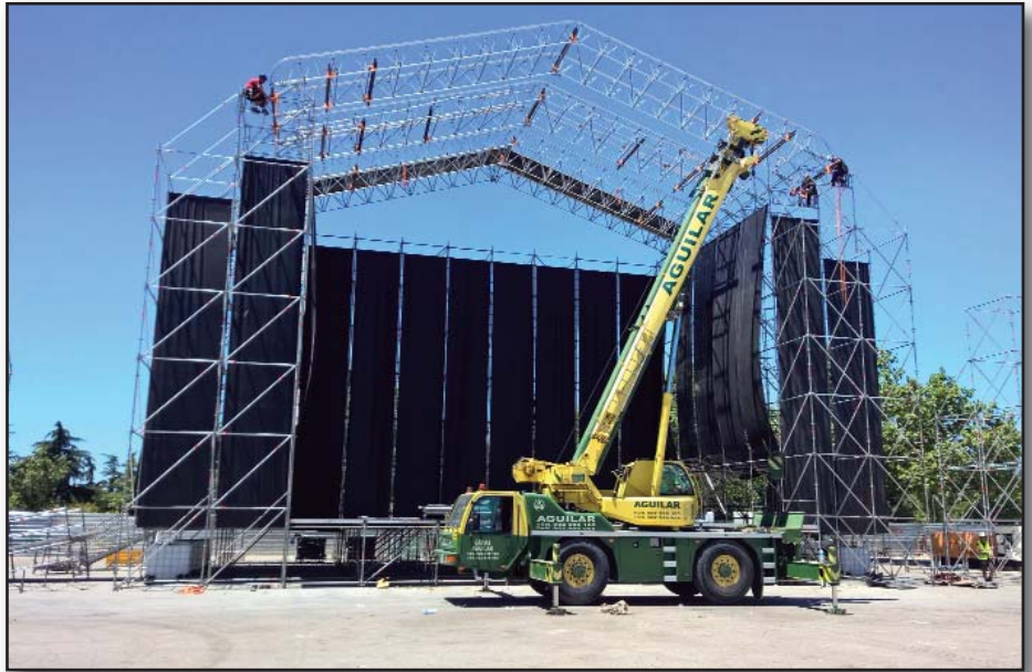
Supervisión del montaje de la estructura layher del escenario dispuesto para los conciertos de las Fiestas Populares de Torrejón de Ardoz del año 2016; en este escenario actuarían, entre otros, Antonio Orozco y Miguel Bosé.
